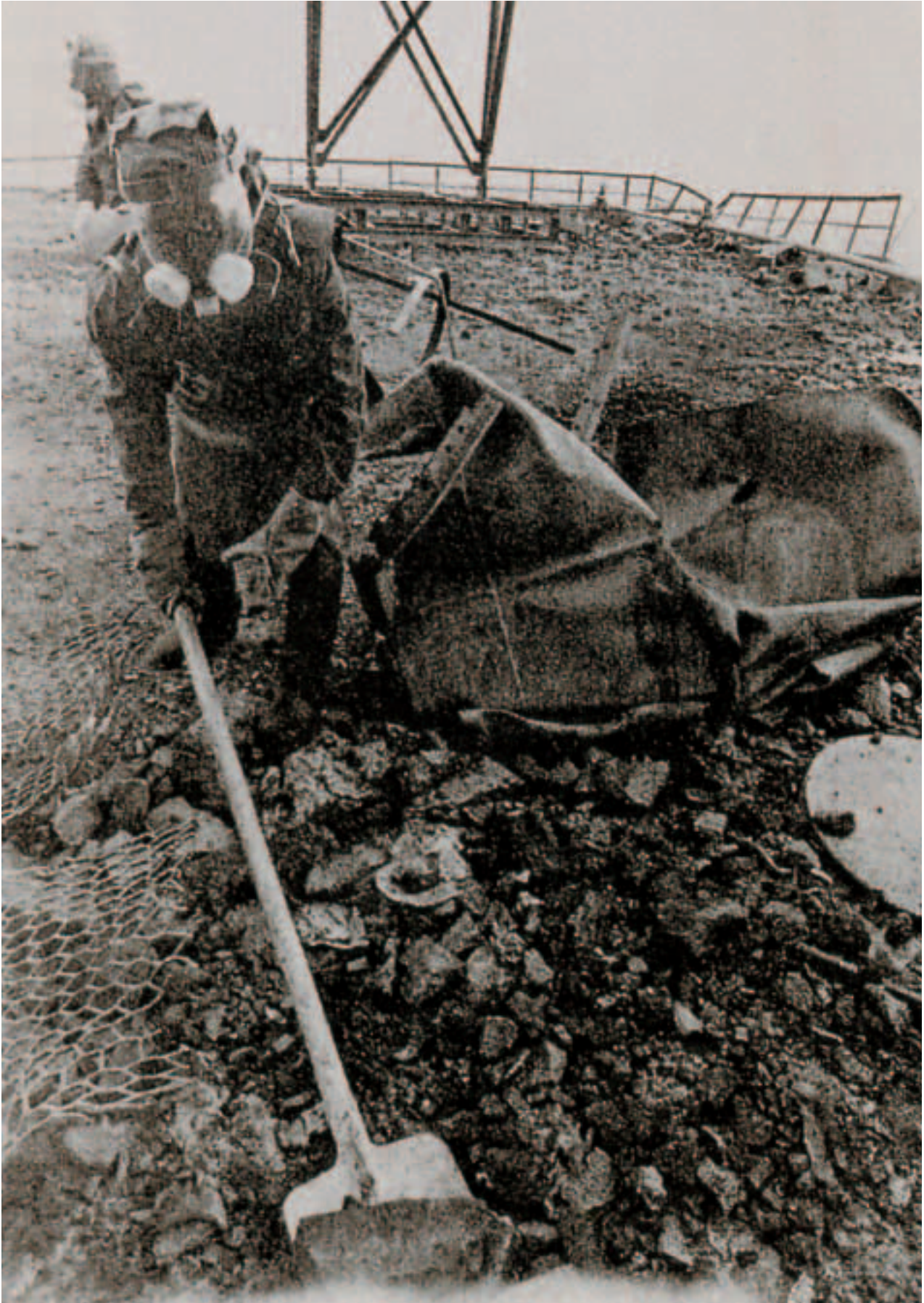
Figure 10: Travaux de déblaiement sur le toit du réacteur détruit
